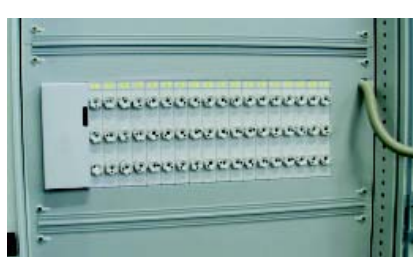
Platzbeschriftung der Vorsicherungen
