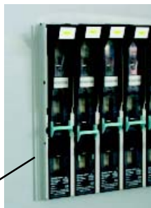
Platzbeschriftung der Vorsicherungen
