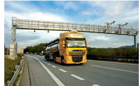
Verkehrstechnikschränke Foto: Kapsch TrafficCom AG
