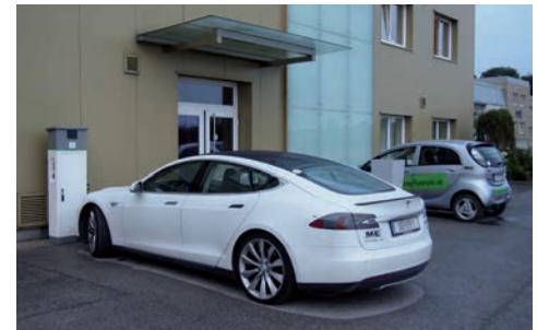
Ladestationen für Elektrofahrzeuge
